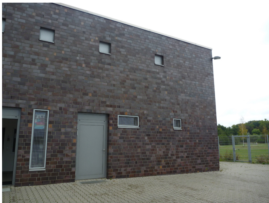
Fassade ohne Dachüberstände
