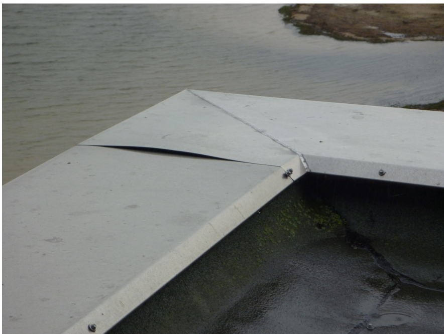
Verschraubte Attikaabdeckung mit aufgebogenem Blech
